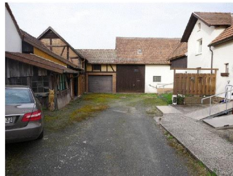
Hof und Nebengebäude Außenbereich
