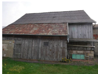
Scheune und einfacher Anbau von der Gartenseite Außenbereich
